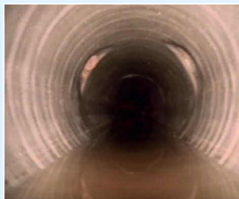
Potrubí po provedené sanaci
